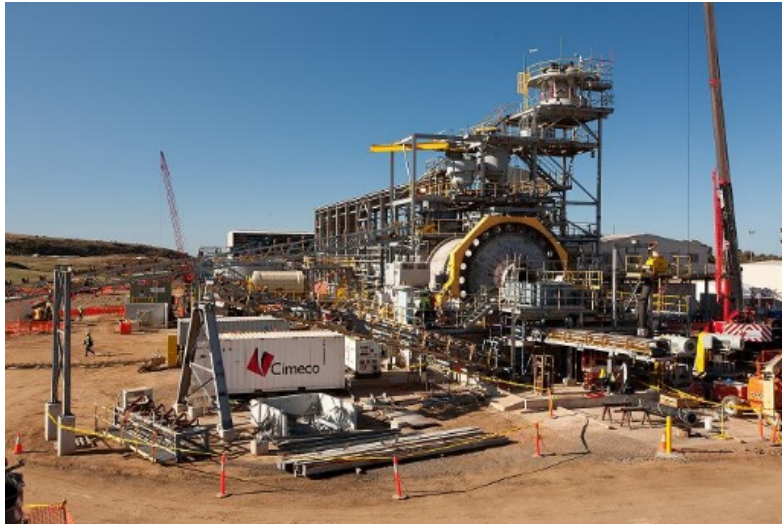
Construction des installations de concassage de la mine de Kanmantoo (Australie) – Extrait de http://www.milchem.com.au
